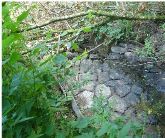
Canal d'écoulement des eaux détérioré par la sécheresse et les ragondins (Grand Prat)
